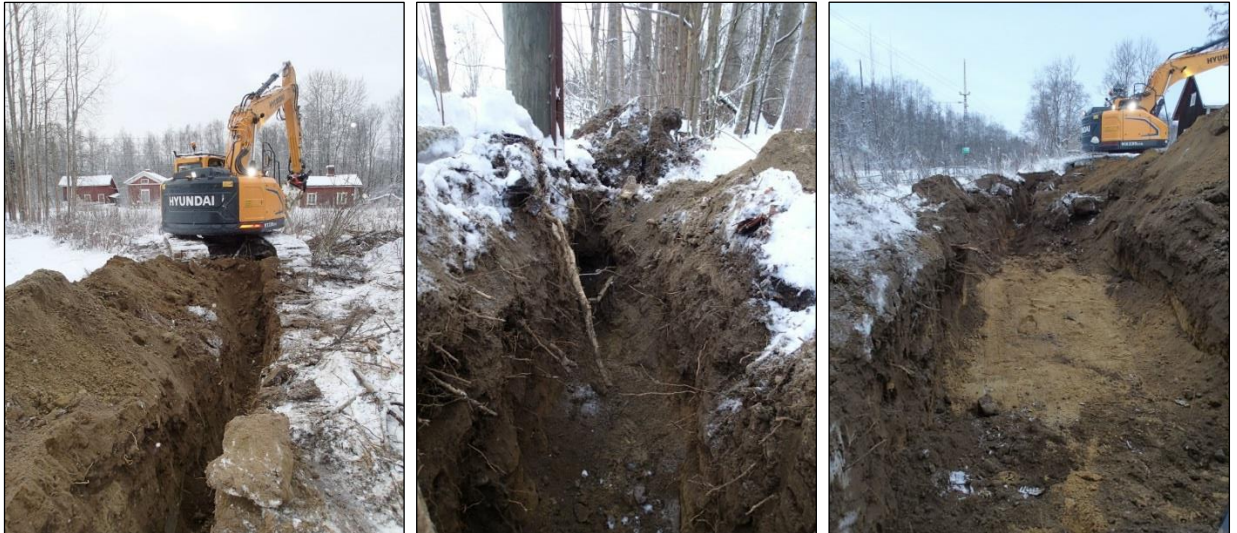
Vasemmalla: Muinaisjäänös alueen eteläpuolisen pellon reunaan kaivettua kaapeliojaa. Länsilounaaseen.
